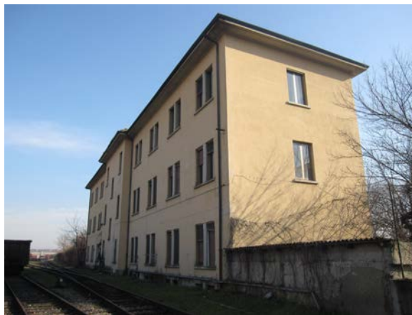
Vista lato Ferrovie
